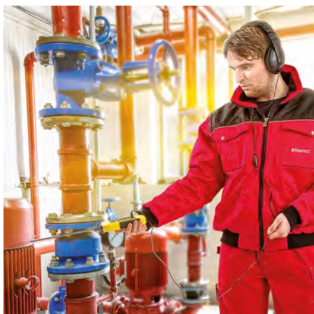
Czujnik ultradźwiękowy pozwala także na szybkie rozpoznanie zużycia pomp i innych maszyn.
