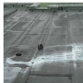
Typowe zastosowania środków typu Luminat obejmuje kontrolę płaskich dachów w celu wykrycia za pomocą barwnika miejsca wymagającego uszczelnienia.
