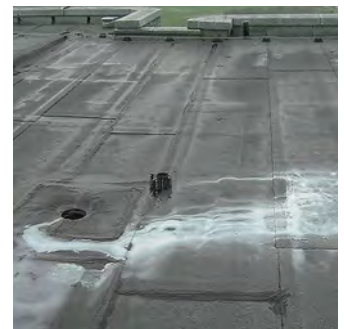
Typische Luminat-Anwendungen sind etwa Flachdachuntersuchungen zum Nachweis einer Abdichtungsfehlstelle mittels Farbstoffprüfung.
