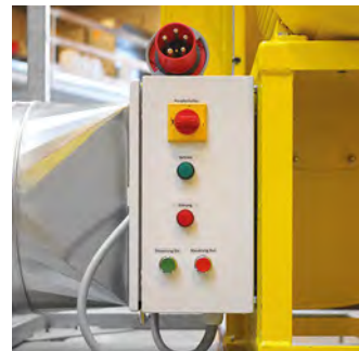
Do seryjnego wyposażenia modeli TFV 600 i TFV 900 należy także obwód gwiazda-trójkąt, zapewniający łagodny rozruch.
