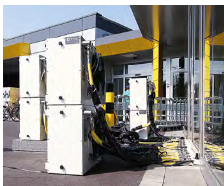
Drzwi wyposażone w złącze PlanoPT mogą pozostać zamknięte. Dzięki temu nie ma potrzeby demontażu połączeń w celu zamknięcia drzwi na noc. W razie potrzeby klimatyzatory mogą pracować przez całą noc.
